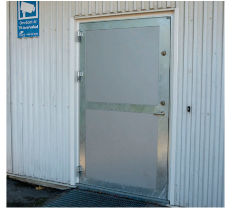
Bredere sikkerhedsdør i sølvlakeret metalplade.
