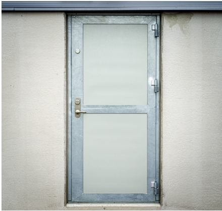
Varmgalvaniseret portbladskarm, beklædt med polyesterlakeret metalplade i silvermetallic.
