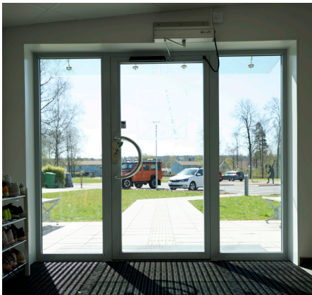
Entréparti med hvidlakeret stålramme.
